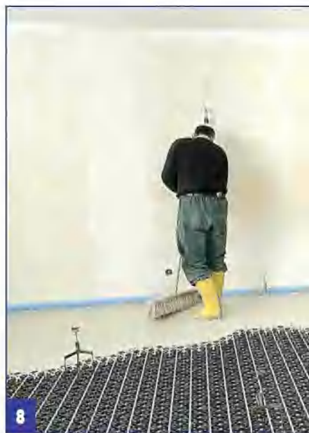
Трубы водно-циркуляционной системы обогрева пола испытывают при повышенном давлении и только после этого заливают бетонной стяжкой.
