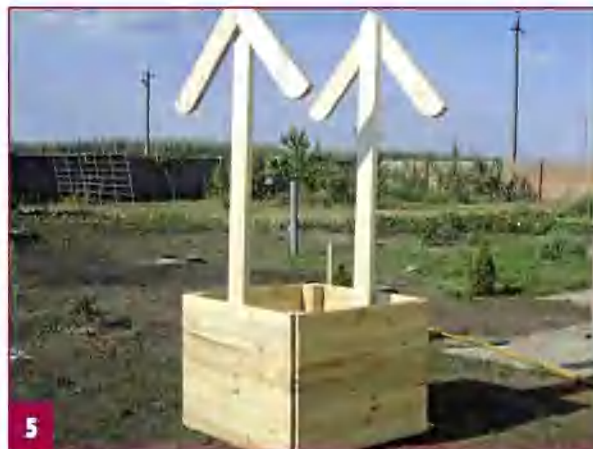
Стойки со стропилами прикрутил с тыльной стороны к доскам обшивки короба.
