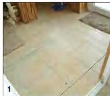
На полу комнаты отдыха уложена керамогранитная плитка. Такой же плиткой облицована крышка люка в подвал.
