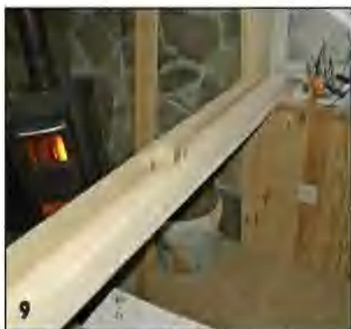
Для фальшбалок использованы бруски 50х50 мм.
