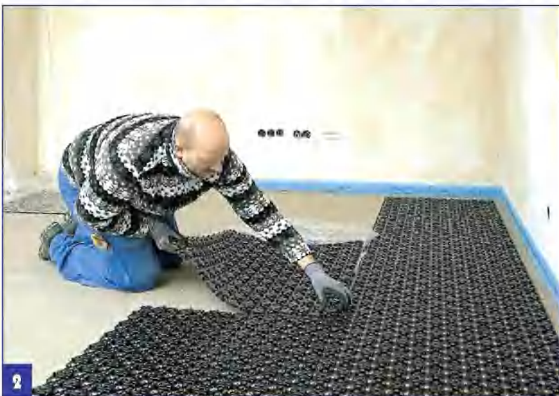
2 После укладки утеплителя и мультифольги приступают к монтажу панелей для укладки труб.
