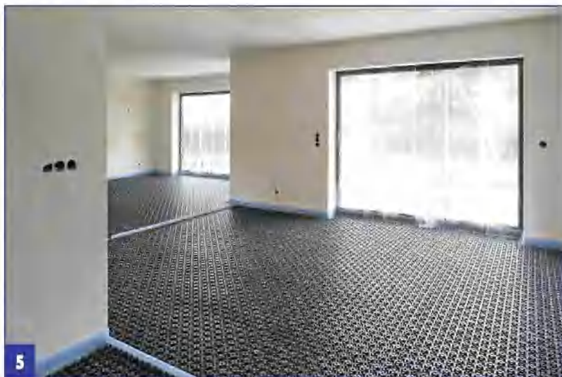
Панелями нужно укрыть всю поверхность пола.
