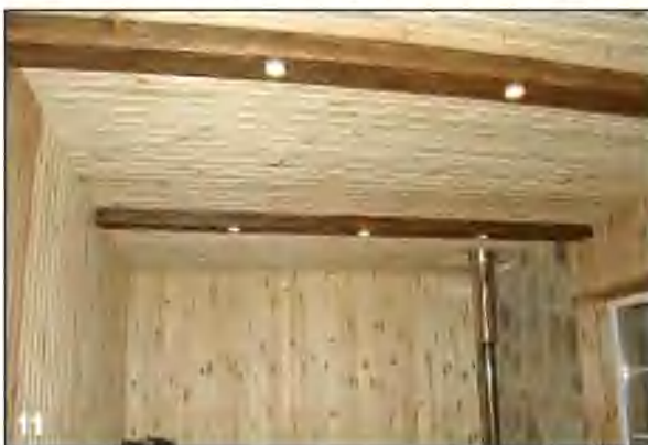
Фальшбалки со встроенными светильниками закреплены на потолке и выделены цветом.
