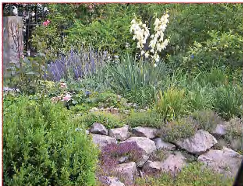
Обрастая растениями, подпорные стенки приобретают дополнительную привлекательность.
