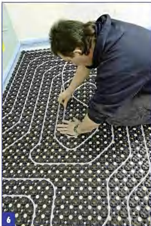
Фиксация трубы на панели производится простым нажатием руки. Гнут трубы также вручную.
