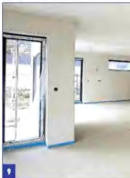
Поверх затвердевшей бетонной стяжки теперь можно уложить подходящее чистовое покрытие.
