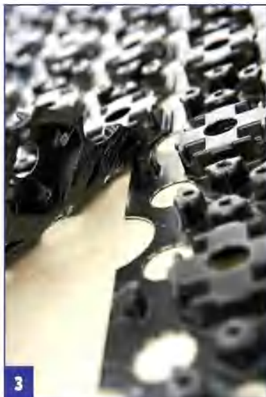
Панели укладывают внахлёст и фиксируют одну на другой на кнопочных соединениях.
