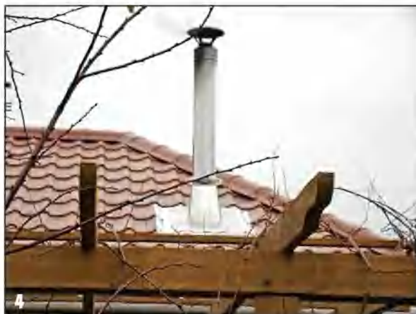
...и крышу установлены разделки.
