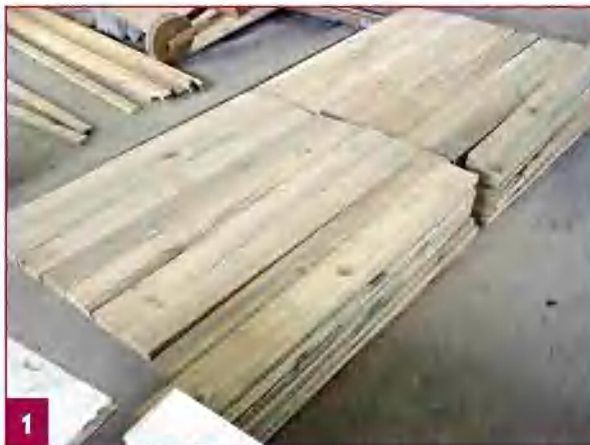
Заготовки для обшивки короба были изготовлены из доски 20х100 мм.
