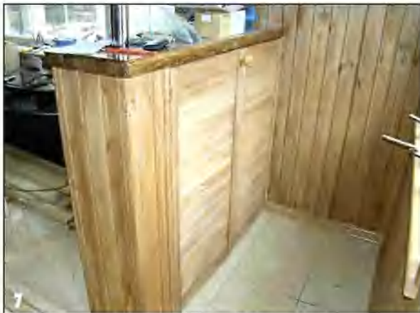
Со стороны «бара» под стойкой навешены жалюзийные дверки, закрывающие полки для хранения посуды и напитков.
